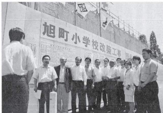
小学校の耐震化工事の状況を視察する上田氏 (左から2人目)ら=27日 川崎市川崎区
